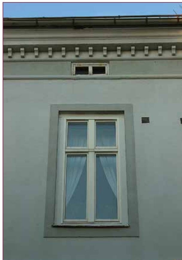
Illustration 109 och 110. Exempel på ett fönster med en så kallad instickskarm, en sorts karm som fästs på insidan av den befintliga karmen. Resultatet blir att tjockleken på karmen ökar samtidigt som ljusinsläppet minskar.
