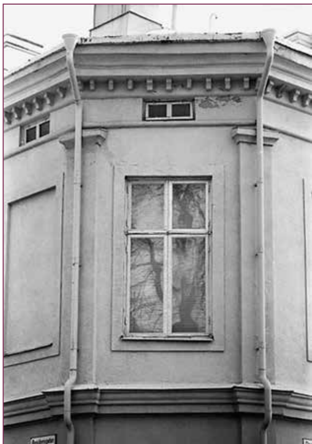
Illustration 109 och 110. Exempel på ett fönster med en så kallad instickskarm, en sorts karm som fästs på insidan av den befintliga karmen. Resultatet blir att tjockleken på karmen ökar samtidigt som ljusinsläppet minskar.
