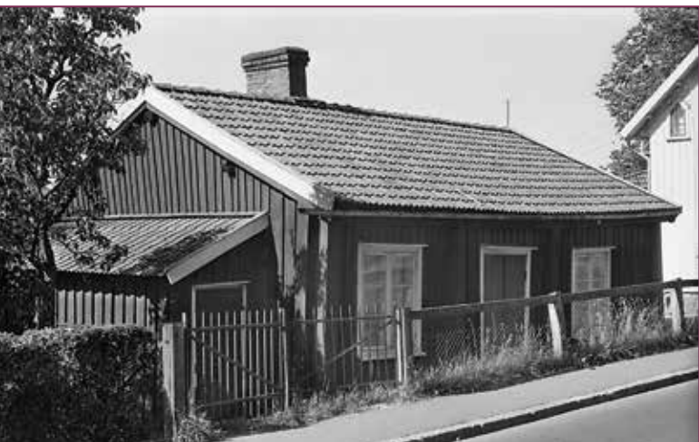
Illustration 120 och 121. Fall B – Bostadshus från 1800-talet som revs trots rivningsförbud i detaljplanen. Den nya byggnadens form är i stora delar densamma som sin föregångares. Takteglet från den äldre byggnaden tillvaratogs, och den nya byggnaden har försetts med samma fönsterindelning, dörrplacering och även knutlådor.
