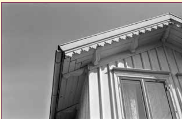
Illustration 49 och 50. Utvändig renovering som resulterat i förändrad karaktär. Åtgärderna har omfattat byte av fönster, exteriör isolering av väggar och byte av paneltyp, med en väsentlig förenkling i utförandet. Att en renovering görs på detta sätt kan bero på flera faktorer. Inte sällan är huvudorsaken av teknisk art, till exempel med syfte att spara energi. Valet av de snabba lösningar i form av standardsortiment som byggvaruhuset erbjuder får också betydelse för slutresultatet.
