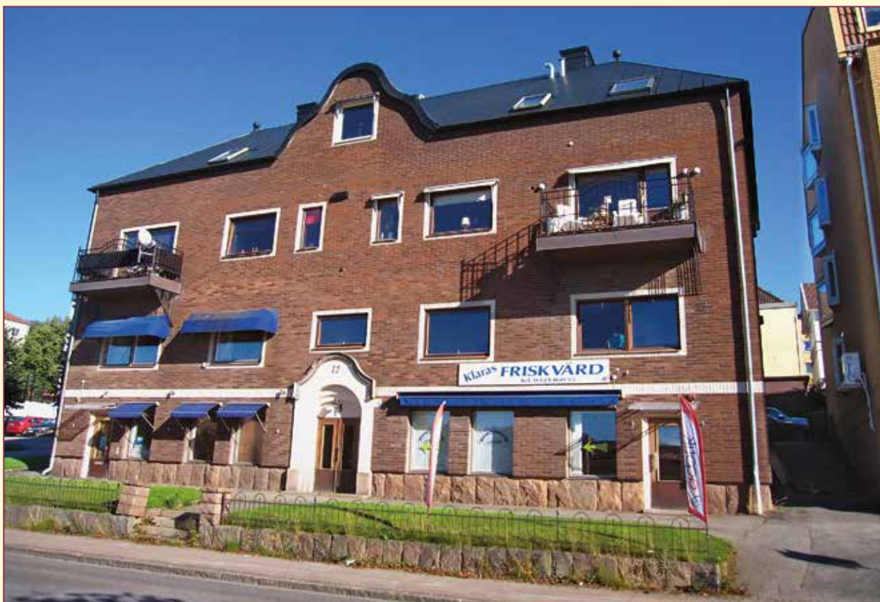
Illustration 56 och 57. Bostads- och affärsfastighet i Ulricehamn som fick nytt utseende 1973, strax efter det att inventeringen gjordes. De panelklädda fasaderna kläddes istället med tegel, och fönstren med korspost togs bort till förmån för trendriktiga perspektivfönster.
