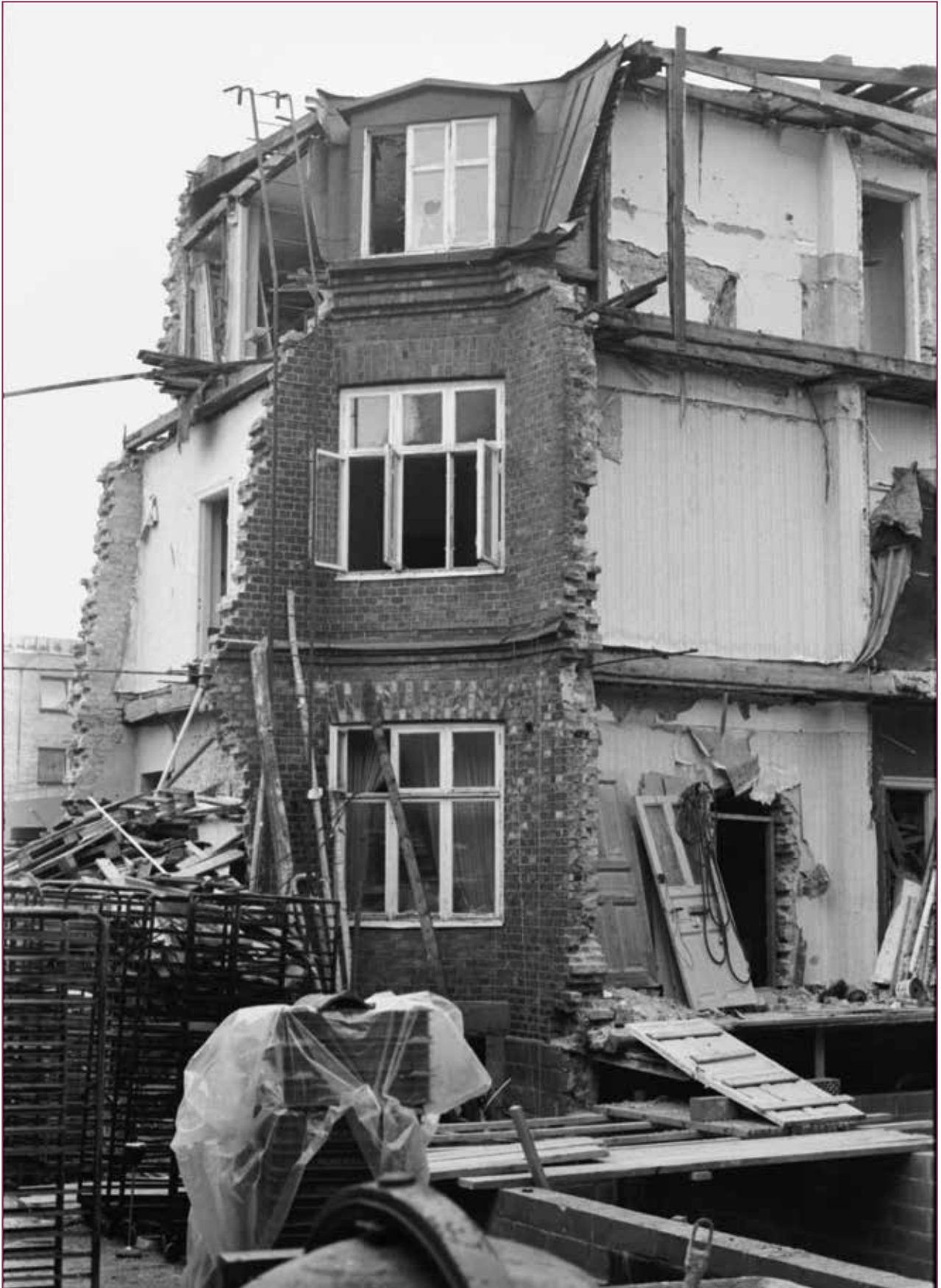
Illustration 76. Bostadshus under pågående rivning 1981.
