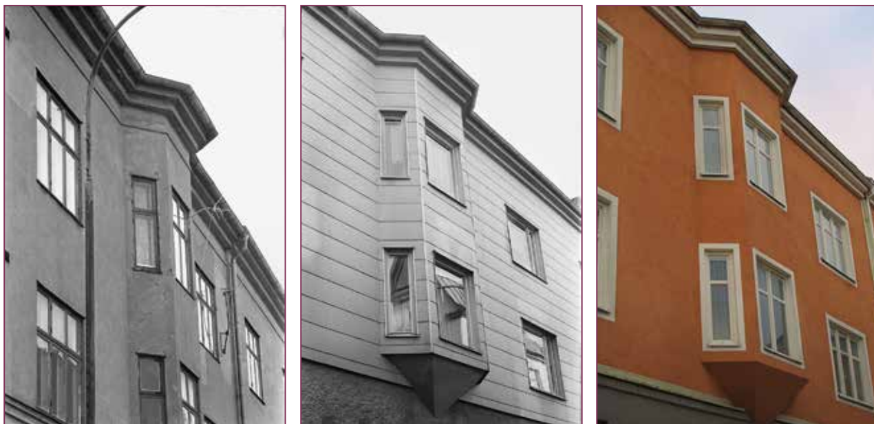
Illustration 51–53. Detta bostadshus har genomgått flera stora förändringar sedan inventeringen på 1970-talet. Bilden i mitten är från 1981 då det skett ett byte av fasadmateriäl och fönster. År 2013 var exteriören delvis återställd – fasaden är återigen putsad och fönstren har fått liknande spröjsindelning som före bytet.
