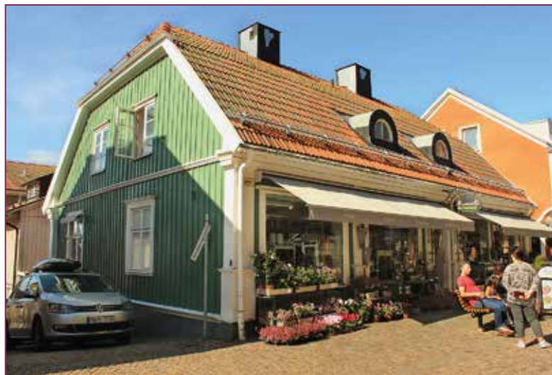
Illustration 119. Fall A – Alla byggnader i kvarteret revs 1984 utom detta, som hade försetts med den starkare bestämmelsen Q – kulturresevat – i stadsplanen.
