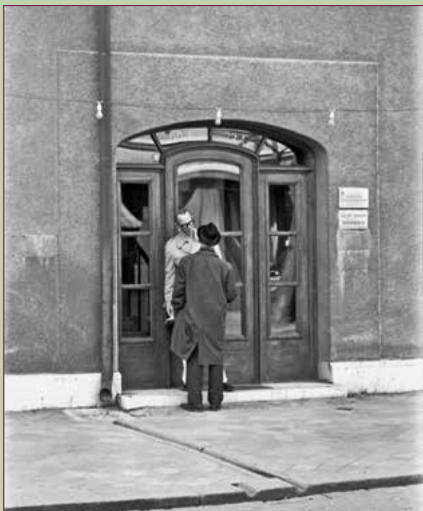
Illustration 39 och 40. Entréparti i trä som ersatts med ett nytt i eloxerat aluminium.
