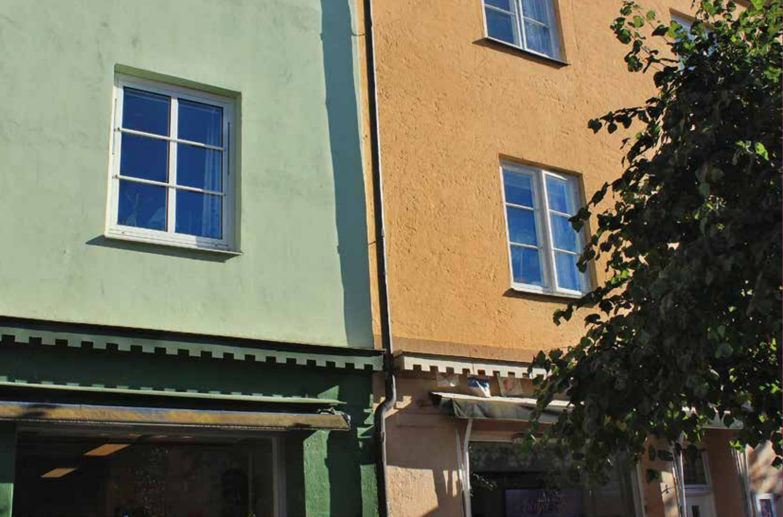
Illustration 108. Jämnåriga grannfastigheter där de sidohängda originalfönstren från omkring 1930 bibehållits till höger, och bytts ut till pivåhängda med lösspröjs till vänster.
