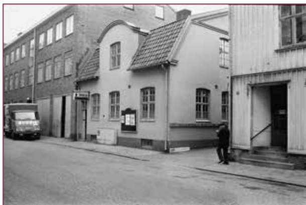
Illustration 24 och 25. Byggnad i Vänersborg, sedd från gatan. Takmaterialet har bytts ut och en tillbyggnad på våningsplanet som sammanlänkar byggnaden med intilliggande fastighet har tillkommit. I övrigt är byggnaden välbevarad och bedömdes ha medelhög förändringsgrad.
