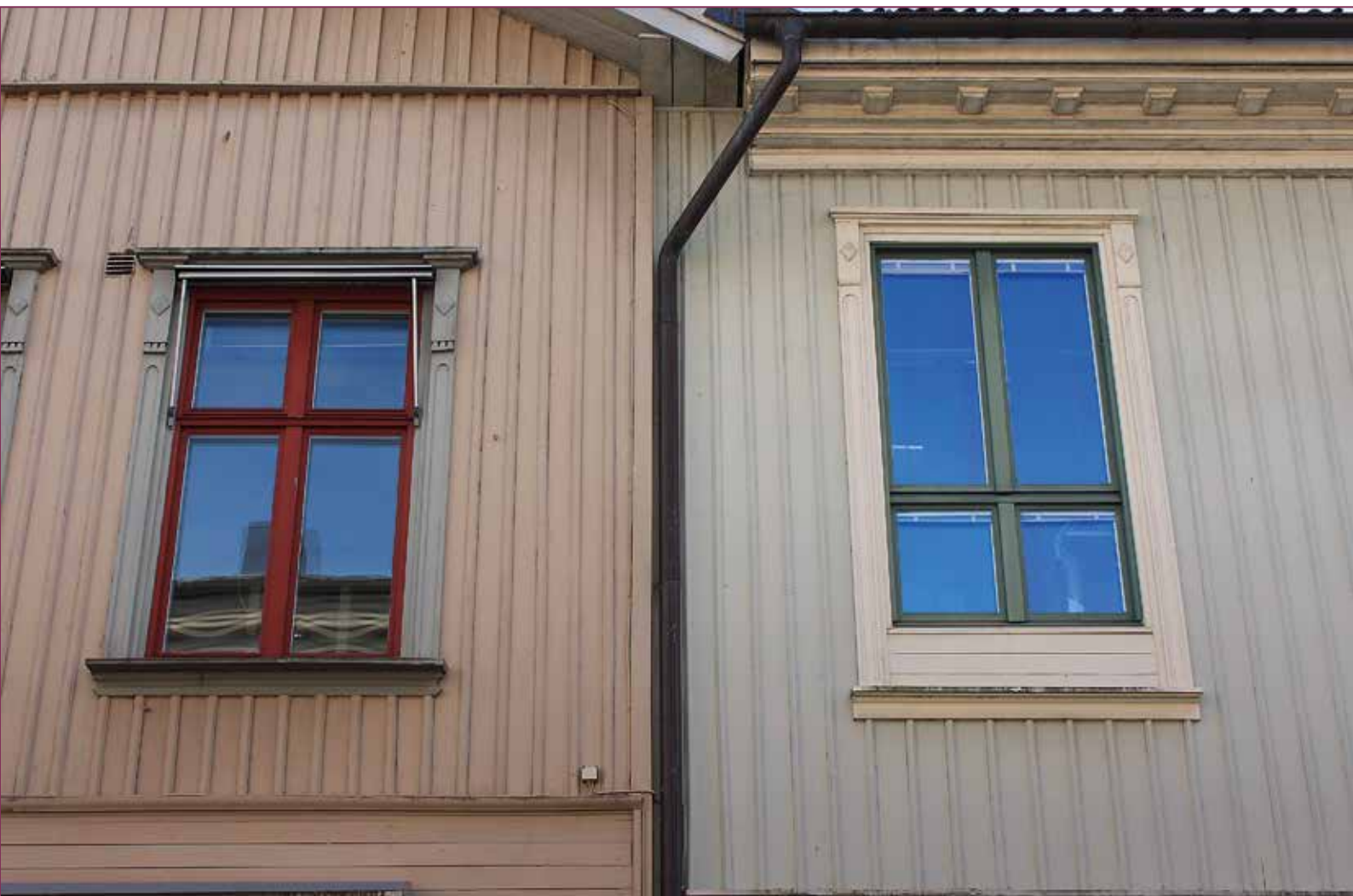
Illustration 128. Fall D. I detaljplanen ställdes höga krav på den nya byggnadskroppens anpassning till den befintligas volym och karaktärsdrag. Anslutningen mellan de båda löstes på detta sätt, där den äldre byggnaden syns till vänster och den från 1990-talet till höger.
