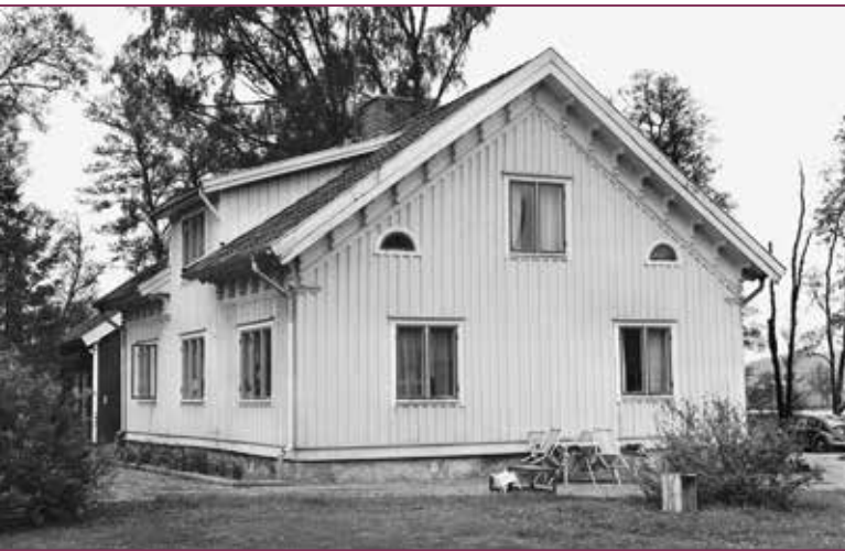
Illustration 14 och 15. Bostadshus med medelhög förändringsgrad. Här finns karaktären kvar i stora drag trots att de nya fönstren har en helt annan indelning än tidigare och trots att taklyftet fått en annan form.
