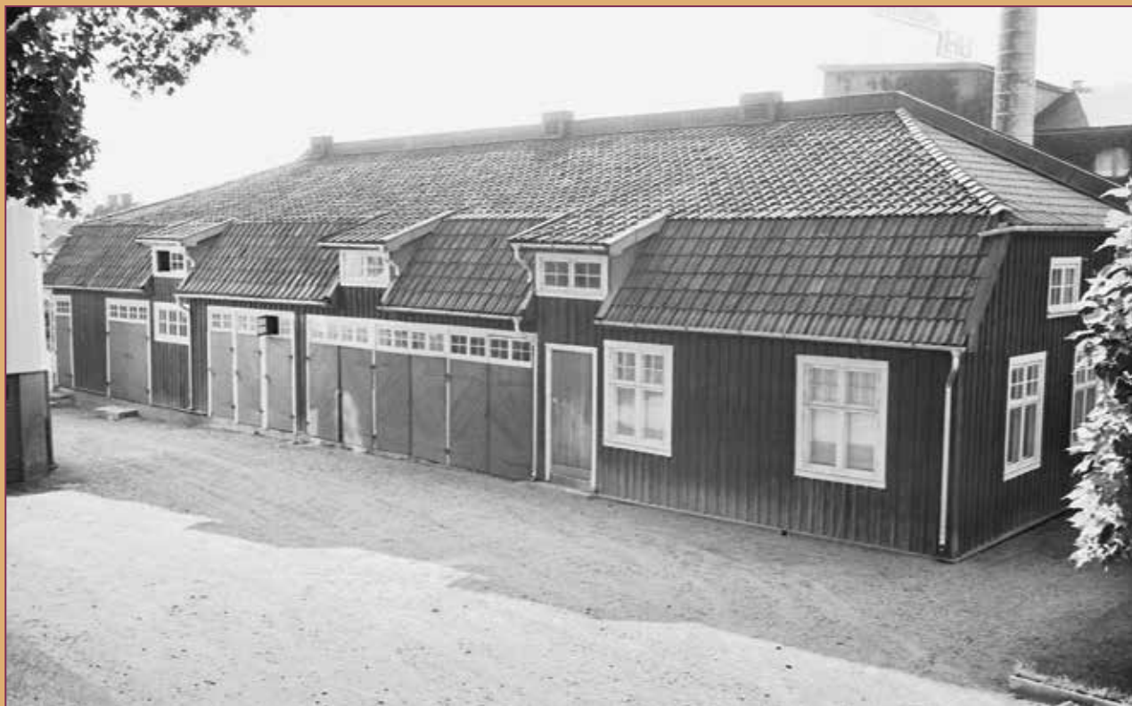
Illustration 62. Numera försvunnen förrådsbyggnad med garage från cirka 1915–20 i Ulricehamn. I detaljplanen från 1995 angavs att den ingick i en kulturmiljö och försågs med rivningsförbud och utförliga bestämmelser kring underhåll och ombyggnad.
