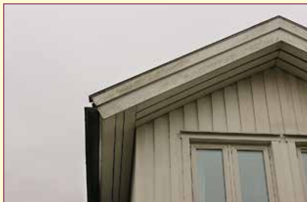
Illustration 49 och 50. Utvändig renovering som resulterat i förändrad karaktär. Åtgärderna har omfattat byte av fönster, exteriör isolering av väggar och byte av paneltyp, med en väsentlig förenkling i utförandet. Att en renovering görs på detta sätt kan bero på flera faktorer. Inte sällan är huvudorsaken av teknisk art, till exempel med syfte att spara energi. Valet av de snabba lösningar i form av standardsortiment som byggvaruhuset erbjuder får också betydelse för slutresultatet.
